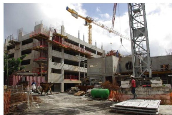
Les travaux en cours du SDIS à Fort de France
